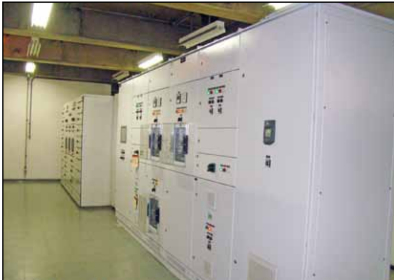
Sistema de ventilação em funcionamento na estação Trianon Masp
