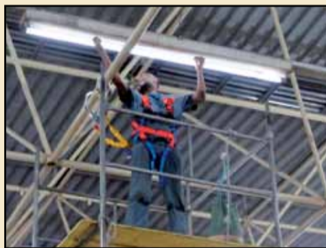
Andaimes ainda são utilizados no Metrô em vez dos cestos aéreos hidráulicos
