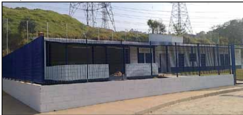
Área de Lazer da Linha 5 em fase final de construção
