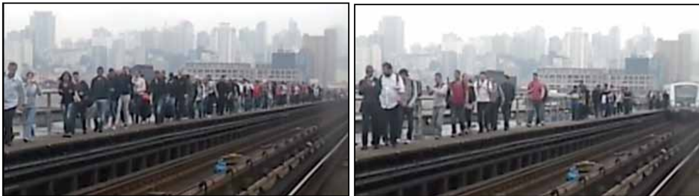
Usuários expostos a riscos: caminham pela passagem de emergência com a via energizada e com o trem em movimento
