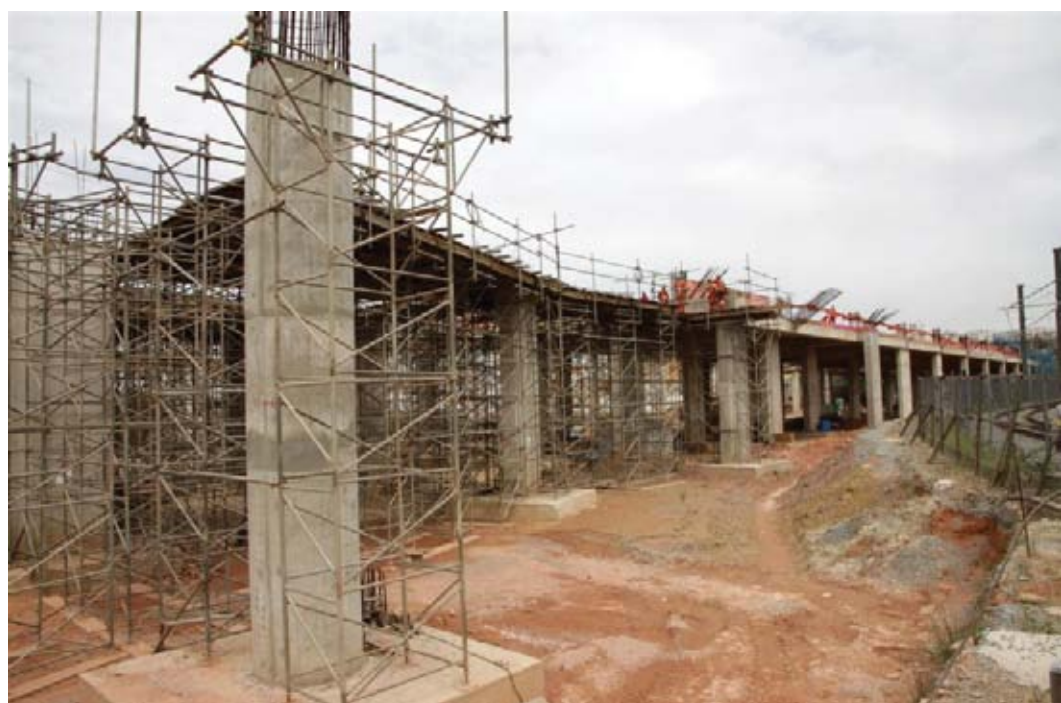
Atrasos nas obras da Linha 4 – Amarela fazem governo de SP rescindir contrato com consórcio responsável pela construção. Na foto: Estação Vila Sônia
