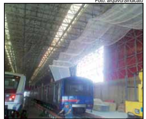
Parte do telhado no PIT foi arrancado durante o vendaval do último dia 07/06
